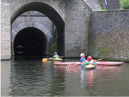
Flusswanderer vor dem Nordportal
