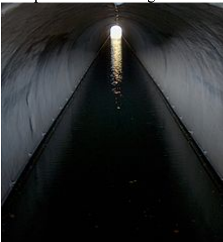
☞ Blick in die Tunnelröhre
