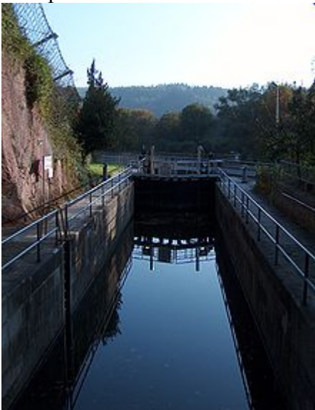
Schleusenanlage am Südportal
